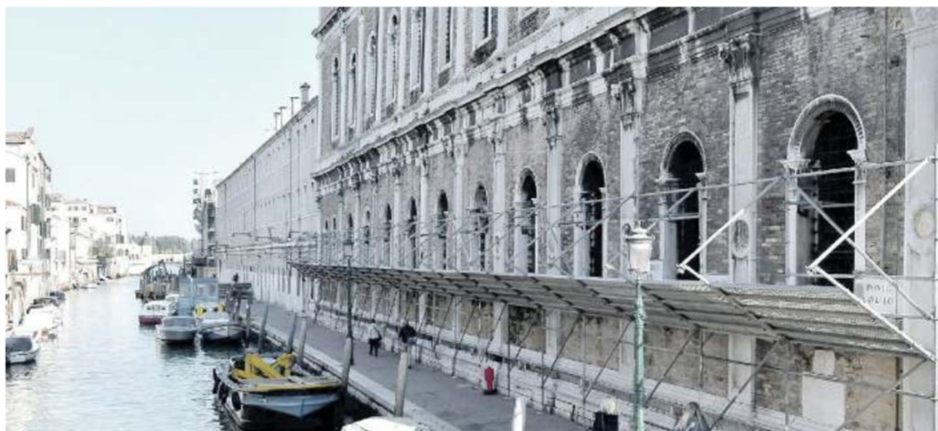
LAVORI IN CORSO Le impalcature per i restauri attorno all'edificio storico del Civile. Sotto Dal Ben con il presidente Zaia in visita al padiglione Jona
